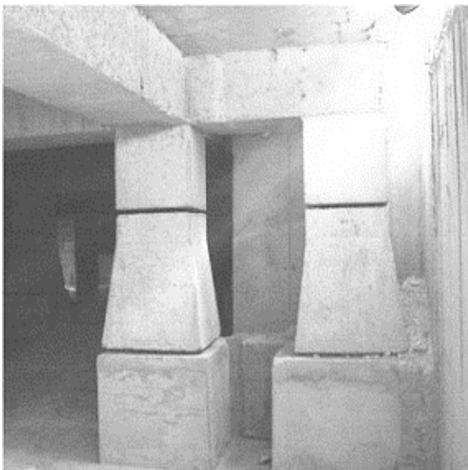
Рис. 13.5. Общий вид кинематической опоры здания
